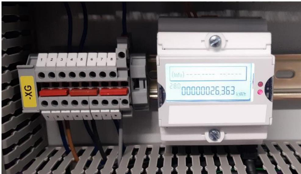
**Bild:** Mit dem Gleichstromzähler IEM-DCR für eine eichrechtskonforme Erfassung von Energiemengen unterstützt die Isabellenhütte die Etablierung von Schnellladestationen für Elektro-Busse im ländlichen Raum. *Bild: ©Isabellenhütte Heusler GmbH & Co. KG*
